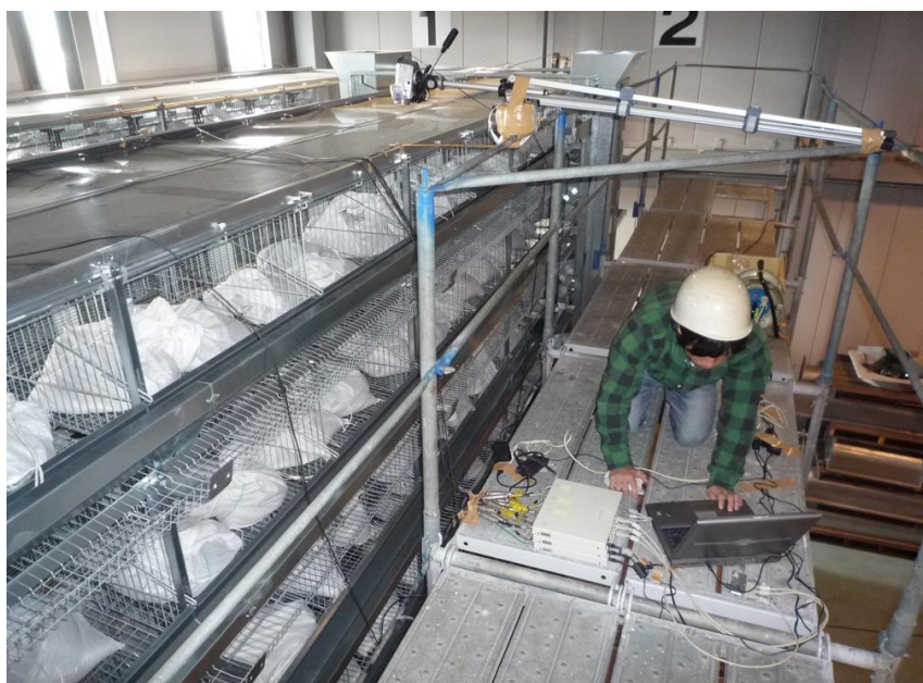
地震対策後のひずみ計測を行う岐阜大学学生
