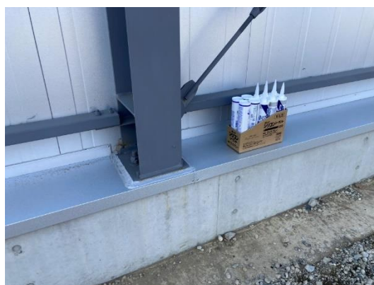
写真4 壁周りの雨水対策例(外から見た写真です)
