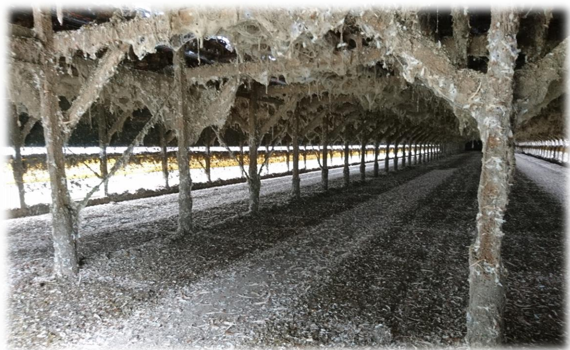
<既存鶏舎の1階部分>
