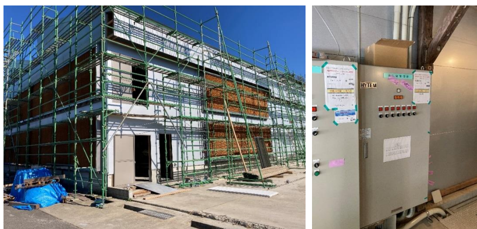
現場搬入後電気盤
