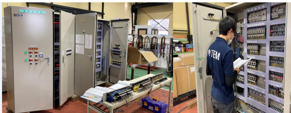
電気盤検査様子
