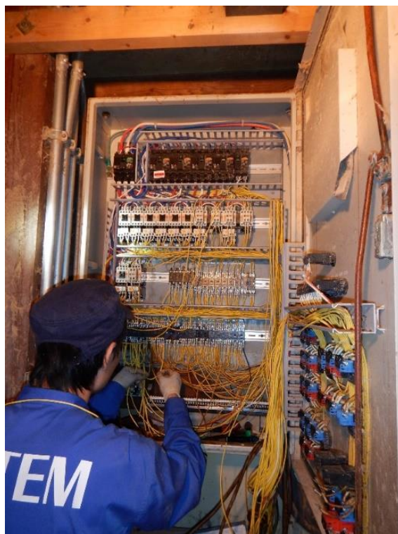
アフター作業の様子
