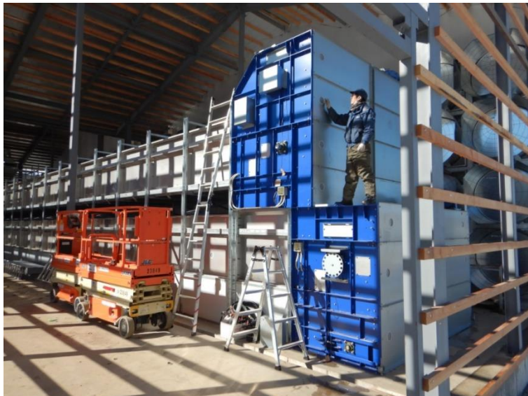
施工が完了したプレートドライヤー 高さ6m、長さ40mにもなる大型機械です
